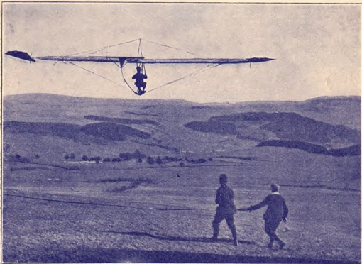
Fig. 45. Rhön-Wettbewerb 1922. Dasselbe Flugzeug von hinten. Gut zu erkennen ist die unabhängige Klappensteuerung.
