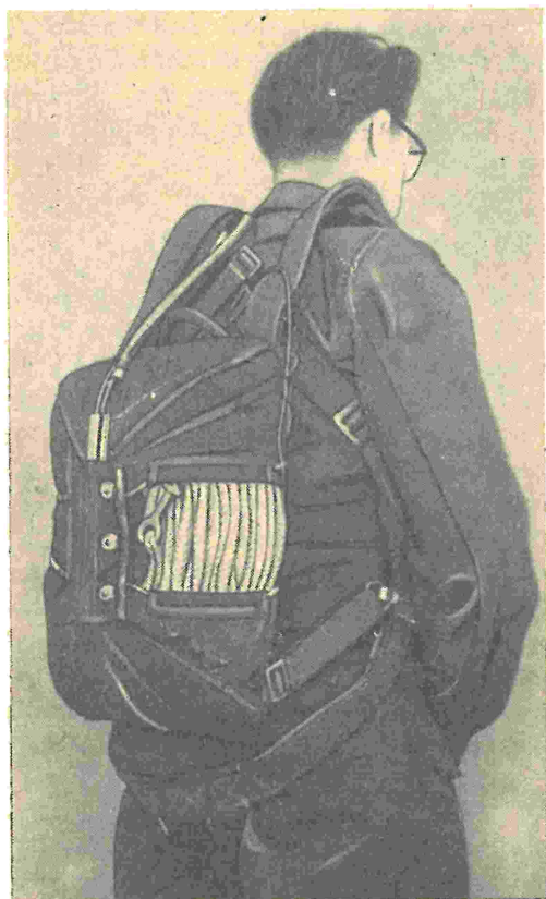
Abb. 142: Der angelegte Rettungsfallschirm „S-27/III-53“
