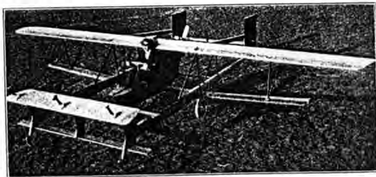
Fig. 114. Budig-Doppeldecker 1922. Hilfsmotor-Segelflugzeug mit vorn liegendem Höhensteuer und automatischer Stabilisierung.
