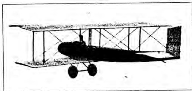
Fig. 69. Farman - Doppeldecker „Sport“ 1922. Verspanntes Rumpfmotorflugzeug ohne Motor.
