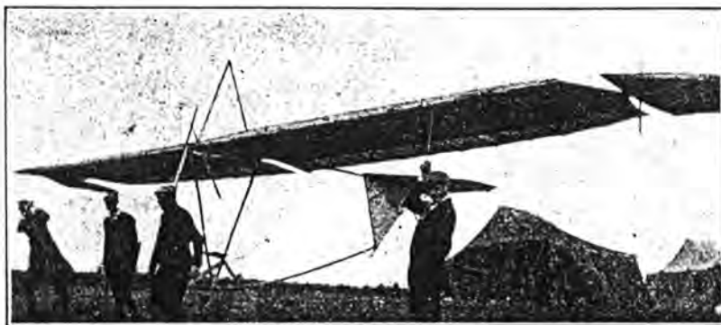
Fig. 49. Schulz F. S. 3 1922. Verspannter Sitzgleiter. Klappensteuerung.
