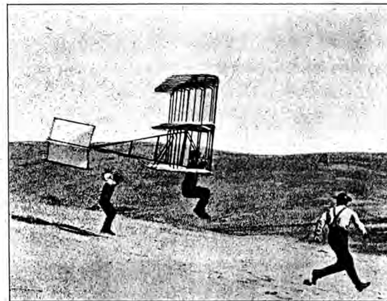
Fig. 41. Start mittels Hängegleiters. Chanute Dreidecker 1902. Offener Gitterrumpf. Aus Moedebecks Taschenbuch, 4. Aufl.
