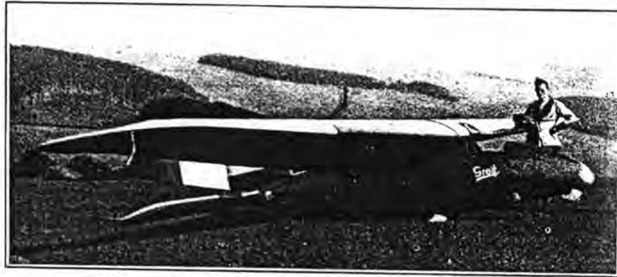
Fig. 82. Hannover-Eindecker „Greif“ 1922. Tief eingebaute Führersitz. Abgerundeter Rumpf.
