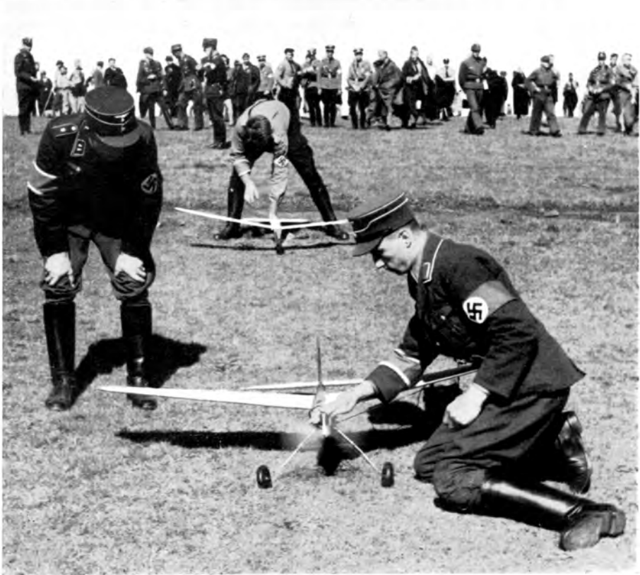
Flugzeugschlepp im kleinen. Ein Segelflugmodell wird von einem Benzinmotorflugmodell in die Höhe geschleppt. Das ist die neueste Startart für Modelle, die beim Reichswettbewerb 1938 zum erstenmal erfolgreich vorgeführt wurde.
