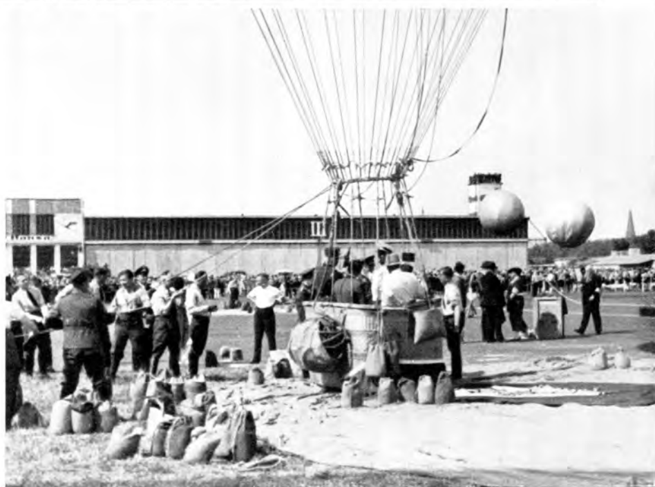
Der Ballon ist hochgelassen. Am Ring, der die Auslaufseile aufnimmt, hängt der zur Fahrt gerüstete Korb. Man sieht das aufgerollte Schlepptau und die Ballastsäcke an der Korbwand. Noch wird der Ballon von der Mannschaft an den Hochlaßseilen gehalten. Rechts vom Ballon herunter hängen die Manövrierseile, Reiß- und Ventilleine.
