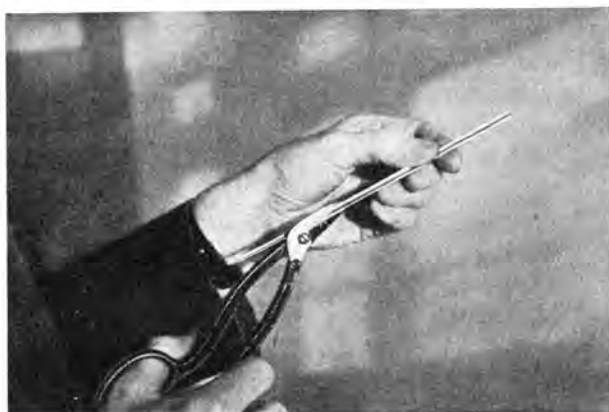
Abb. 5. Richtiges Beschneiden mit der Meco-Blechschere.
