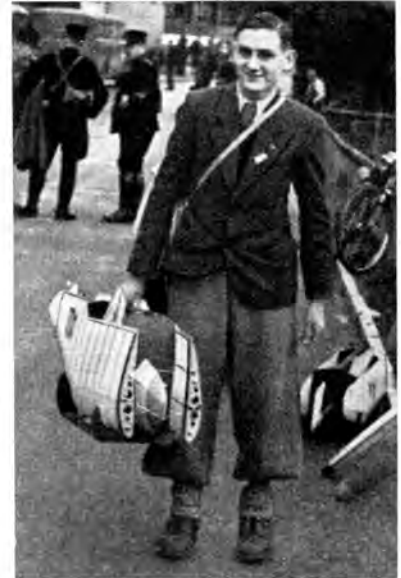
Abb. 6. Praktisches Transportgestell eines Schweizer Modellfliegers zur Beförderung der Einzelteile eines Segelflugmodells.
