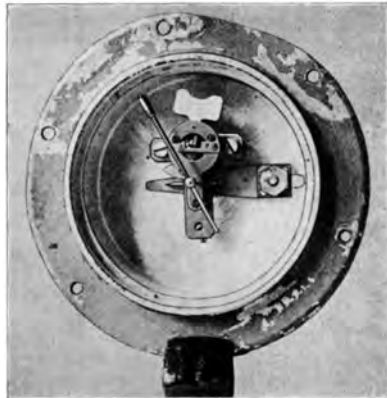
Abb. 262. Staudruck-Fahrtmesser mit Kautschukmembrane (franz.).
