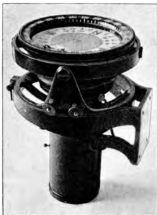
Abb. 193. Rumpfkompas (Gesellschaft für Nautische Instrumente).
