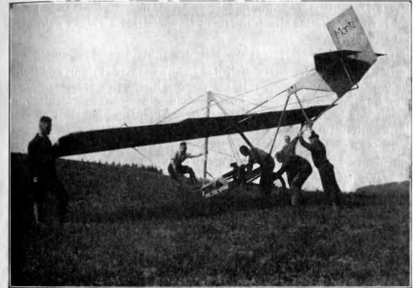
Abb. 8. Einheitschulmaschine „Grunau“ wird auf den einrädriigen Transportwagen gesetzt.
