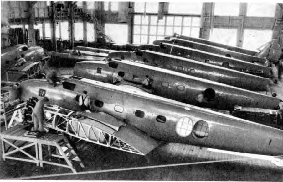
Abb. 84. Rumpf-Montage der Boeing Airplane Company.
