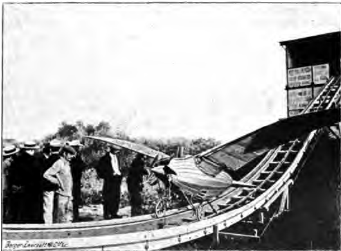
Fig. 34. — Pigeonnier et plan incliné Roux. Le personnage du premier plan monte l'oiseau pendant les expériences.
