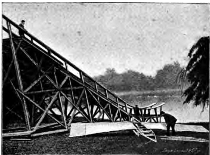
Fig. 28. — Danger des plans inclinés : un vent de travers a renversé l'appareil pendant la descente.
