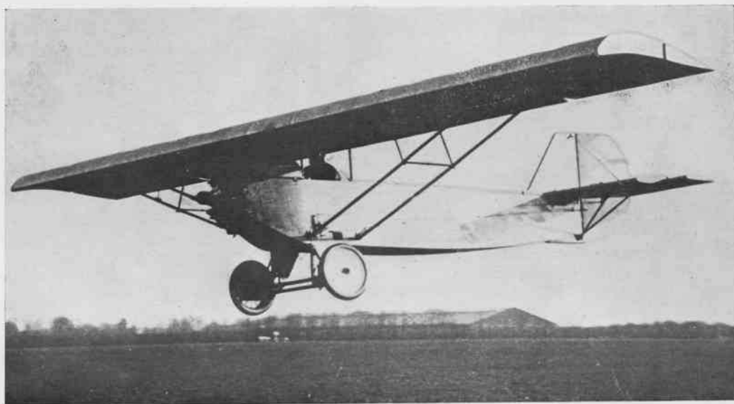
Appareil avec moteur Salmson 40 CV. et train d'atterrissage « école ». Constructeur GUÉDON.
