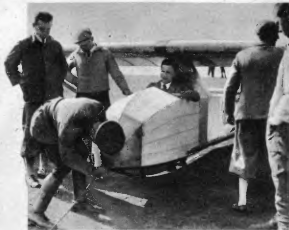
Das Gummiseil wird am Bug des Segelflugzeuges eingehakt
