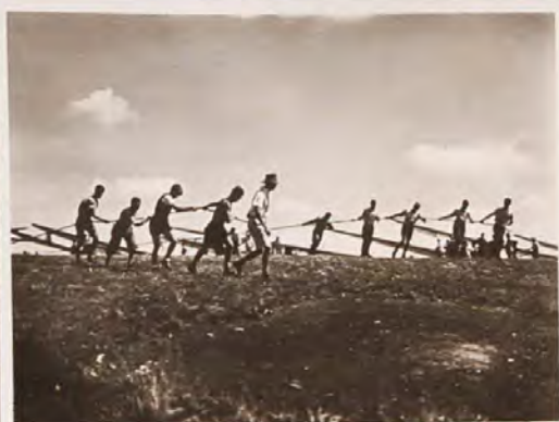
Bild 206. Startmethoden: Ausziehen des Startseiles
