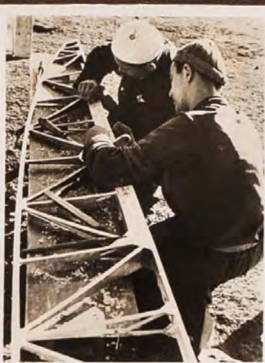
Bild 175. Reparatur eines Querruders
